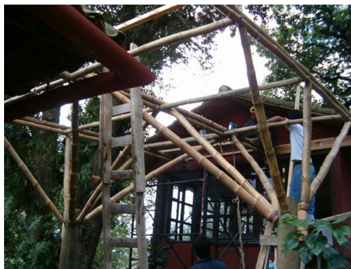
Figura 5. Vista de la estructura de bambú.
