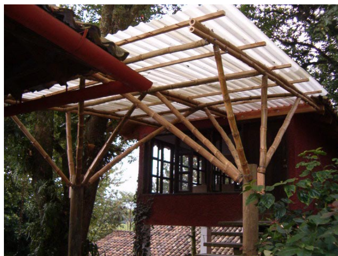
Figura 4. Pequeña cubierta de bambú con dimensiones de 400 x 600 cm.
