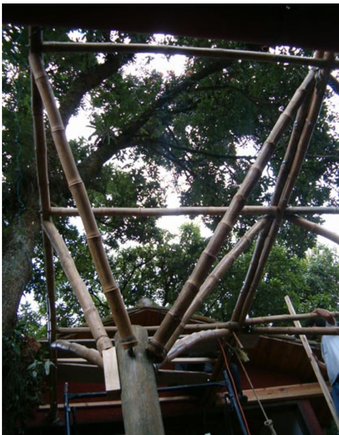
Figura 6. Vista inferior de la cubierta de bambú.
